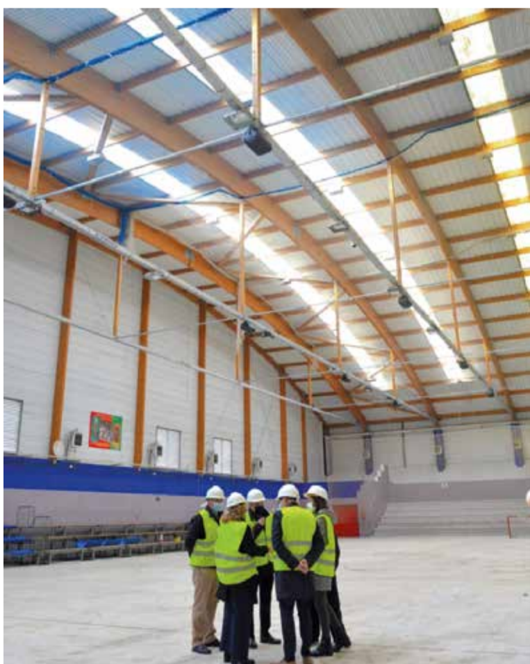
Remodelación de la cubierta de la pista de hockey del Polideportivo Santo Domingo
