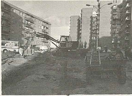
Obras del colector de la calle de Cisneros.
