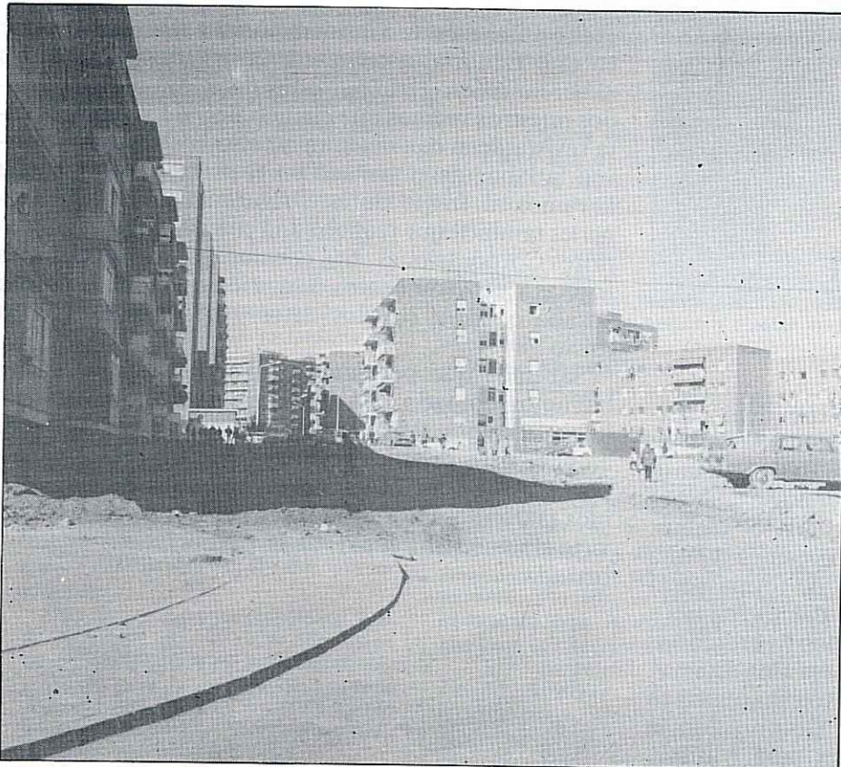
La pavimentación se realizó como objetivo prioritario. Un ejemplo es la calle de Sierra de Albarracín.
