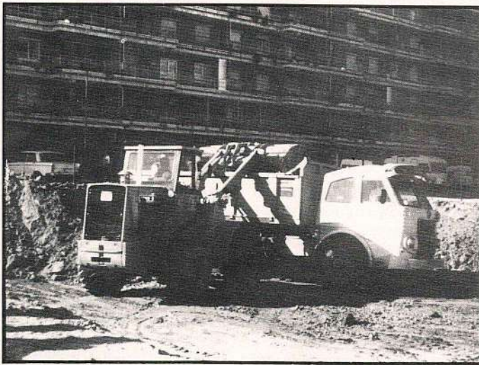
Una primera fase de las obras del «Hogar del Pensionista».
