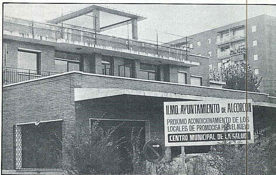
El local para el Centro Municipal de la Salud, situado en la Avenida de Lisboa.
