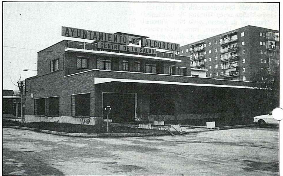
Así ha quedado el Centro Municipal de la Salud
