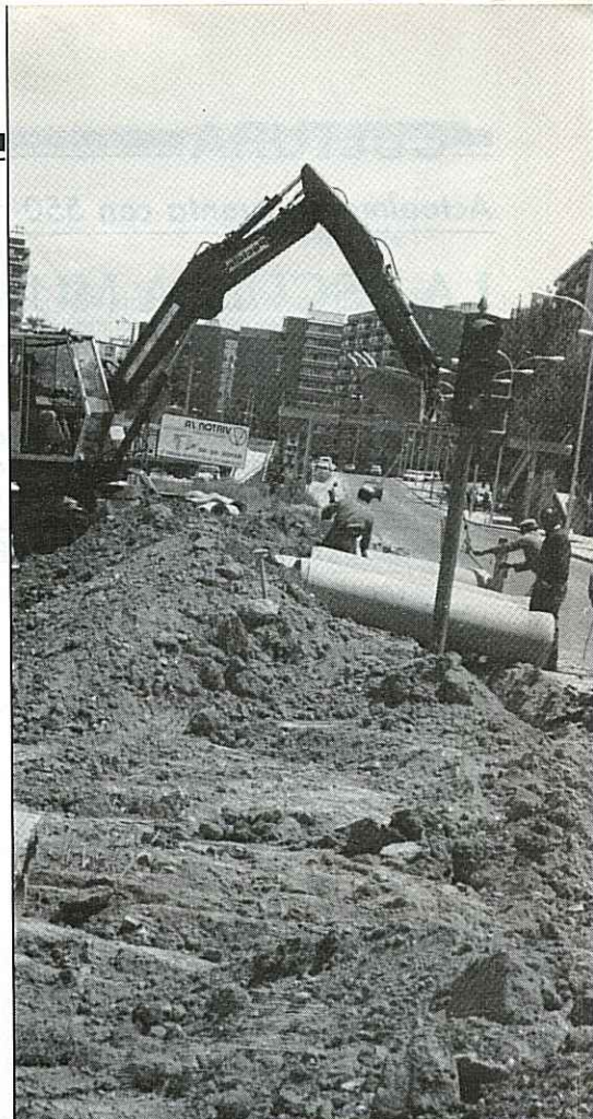
Las obras de la margen derecha de la carretera de Leganes
