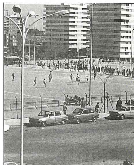
Los terrenos calificados de escolares son los actualmente ocupados por los módulos prefabricados (en la parte superior izquierda de la foto). Se logrará, sin perjuicio para la zona deportiva, la construcción de un centro definitivo de EGB
