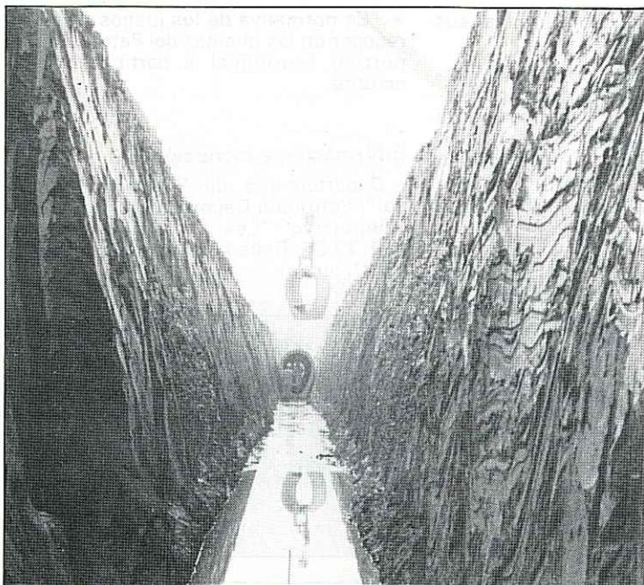
Zanja en donde se introducen los ovoides de hormigón prefabricado. La profundidad es de once metros
