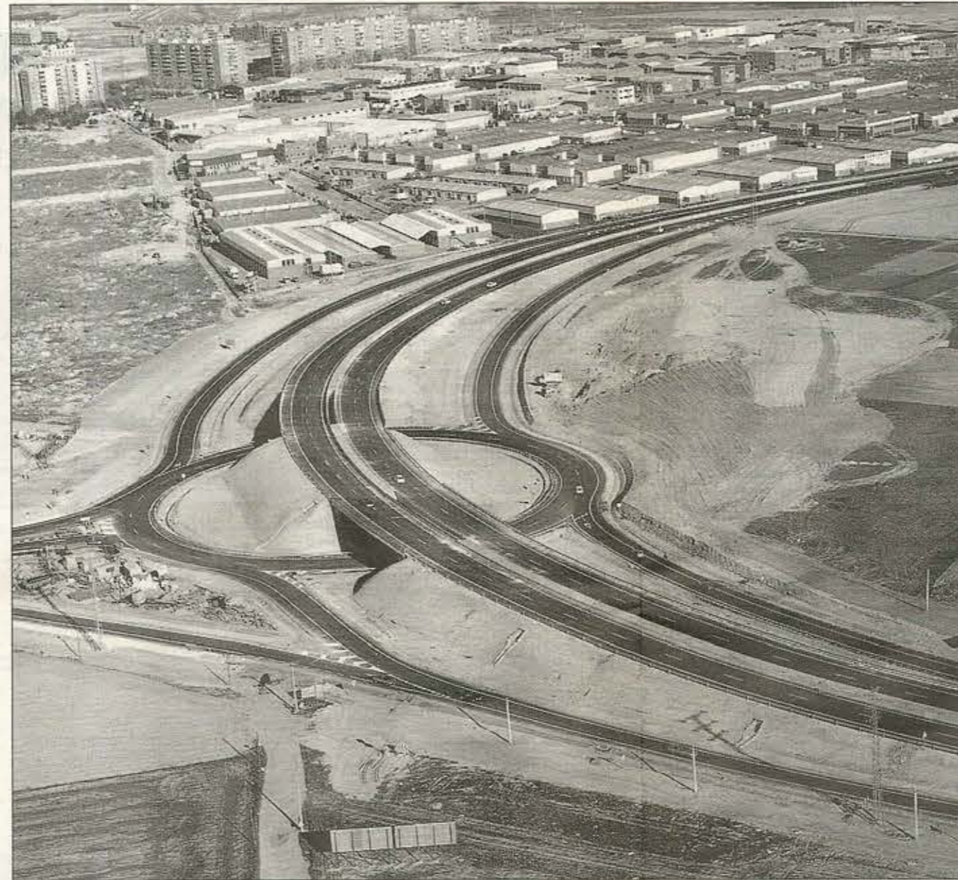
La construcción del enlace de Alcorcón viene a mejorar sensiblemente las condiciones de circulación y seguridad vial.
