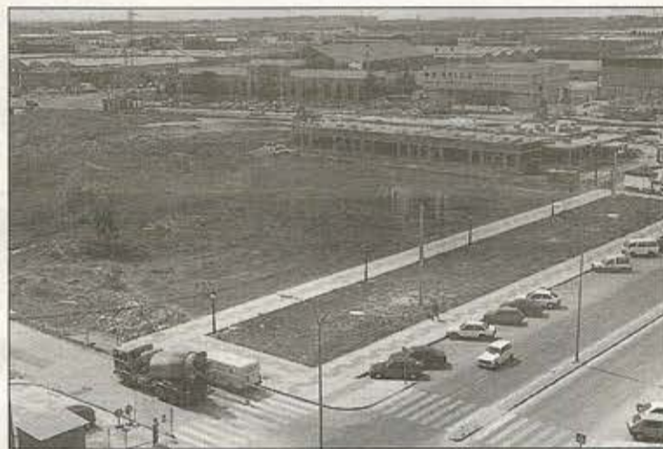
Los terrenos donde se edificarán las 490 nuevas viviendas están ubicados justo enfrente de la primera promoción.
