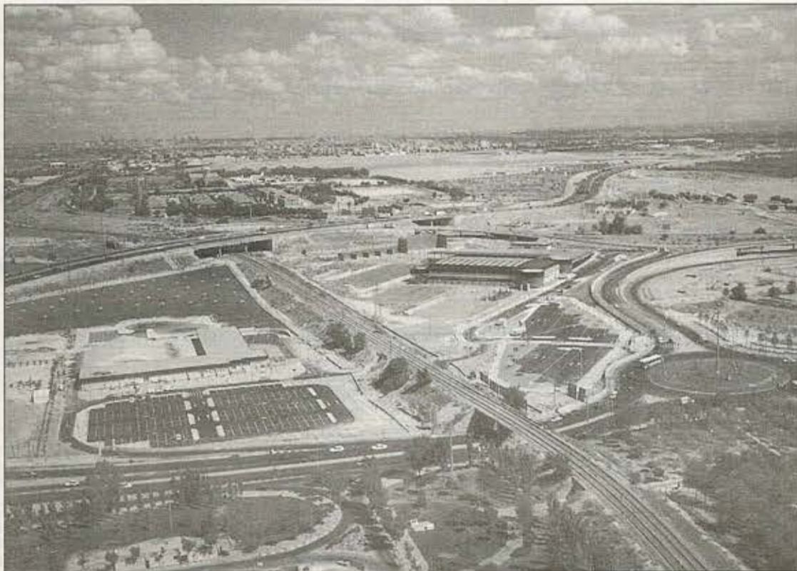
Vista aérea del polideportivo La Canaleja, con el que se completa una racional distribución de instalaciones por toda la ciudad.
