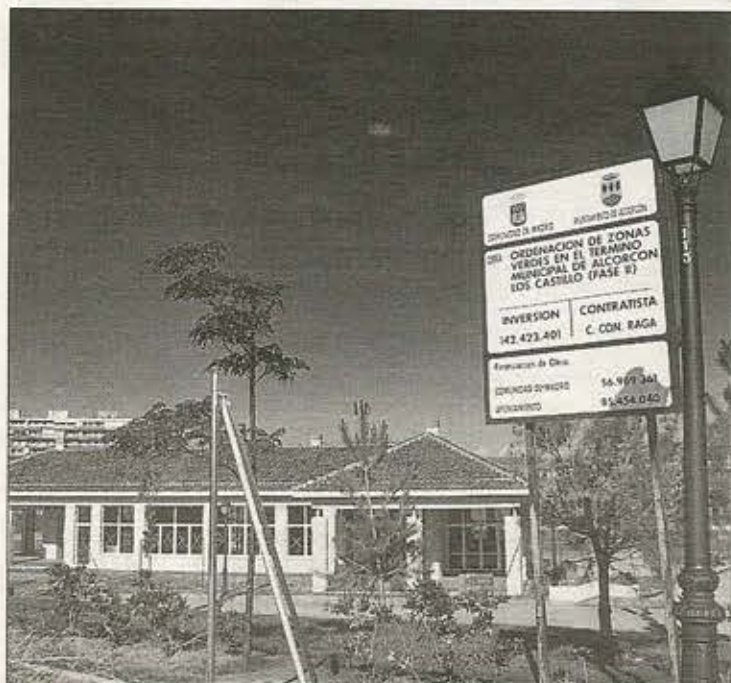
La cafetería, una de las grandes obras de la segunda fase, está prácticamente terminada.
