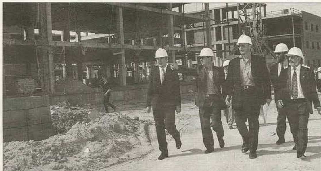
En primer plano y de izquierda a derecha, el Concejal de Salud de la CAM, el Director Provincial del Insalud, el arquitecto del Hospital, y el Alcalde de Alcorcón, visitaron el pasado mes las avanzadas obras del Hospital.
