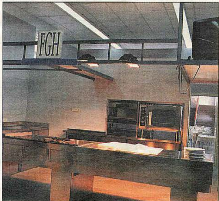
Instalaciones del Centro de formación de hostelería
