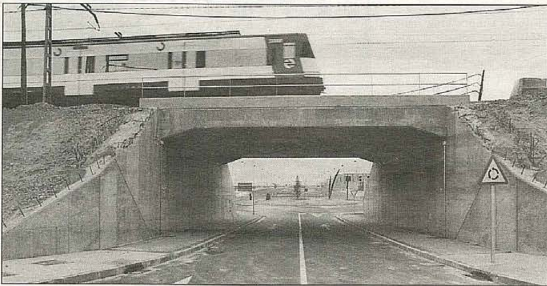
Nuevo acceso para el Parque Oeste
