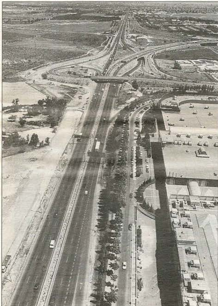
Imagen de la N-V antes de las obras de ensanche
