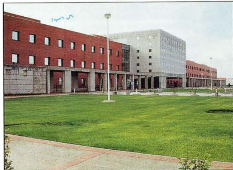
Fachada principal del Hospital General de Alcorcón.
