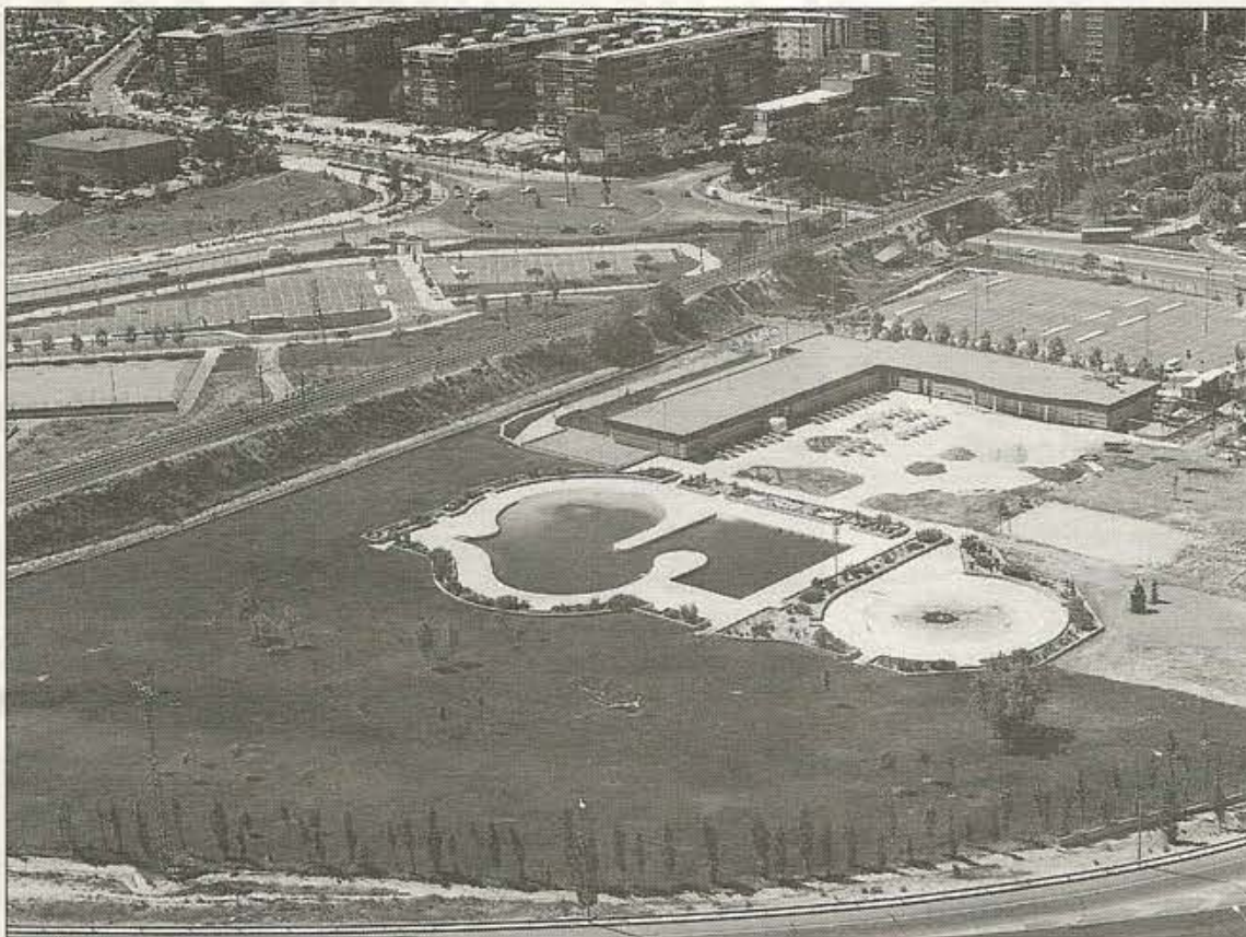
Vista aérea del polideportivo de La Canaleja. Cerca de las piscinas al aire libre se construirá el recinto de la piscina cubierta
