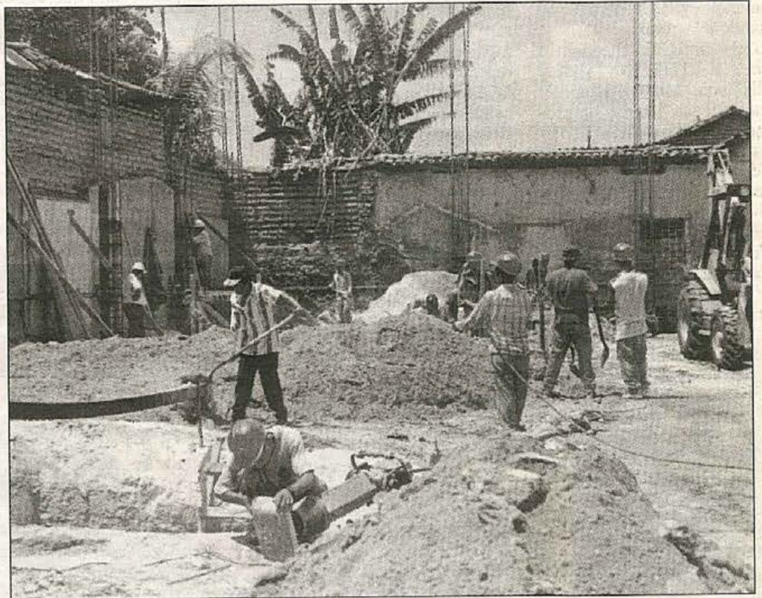
Imagen de las obras de construcción del mercado Plaza de España de Nejapa
