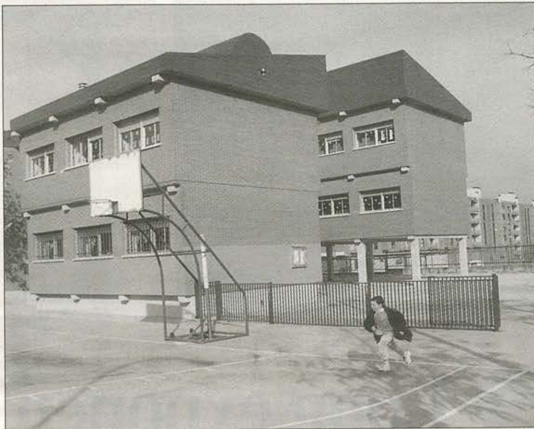
Imagen de las nuevas instalaciones.
