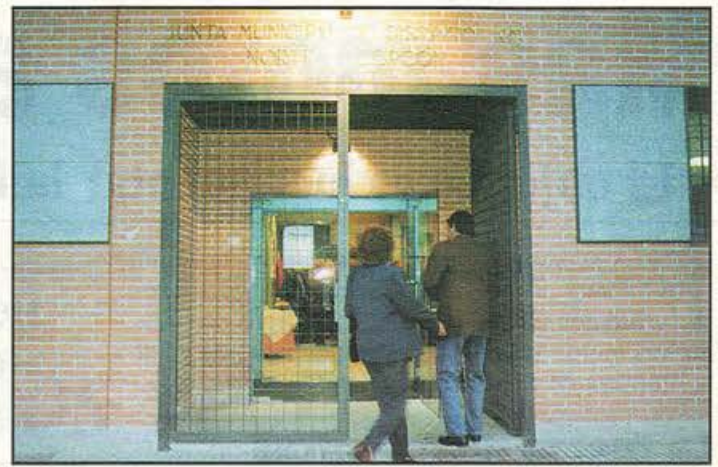
Fachada de la nueva Junta de Distrito Norte
