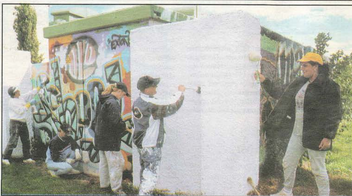
Una brigada de limpieza elimina las pintadas en la Residencia de Mayores de la Avenida Pablo Iglesias
