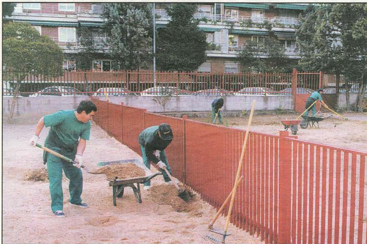
Miembros del taller Mejora Ambiental realizan trabajos en un colegio del barrio Parque de Lisboa
