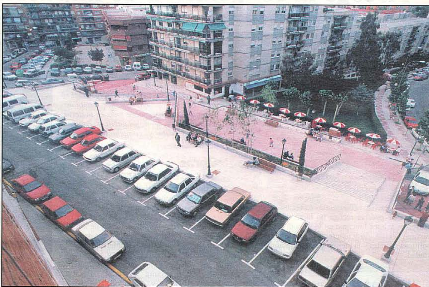
Imagen panorámica de uno de los tramos de la avenida de Polvoranca
