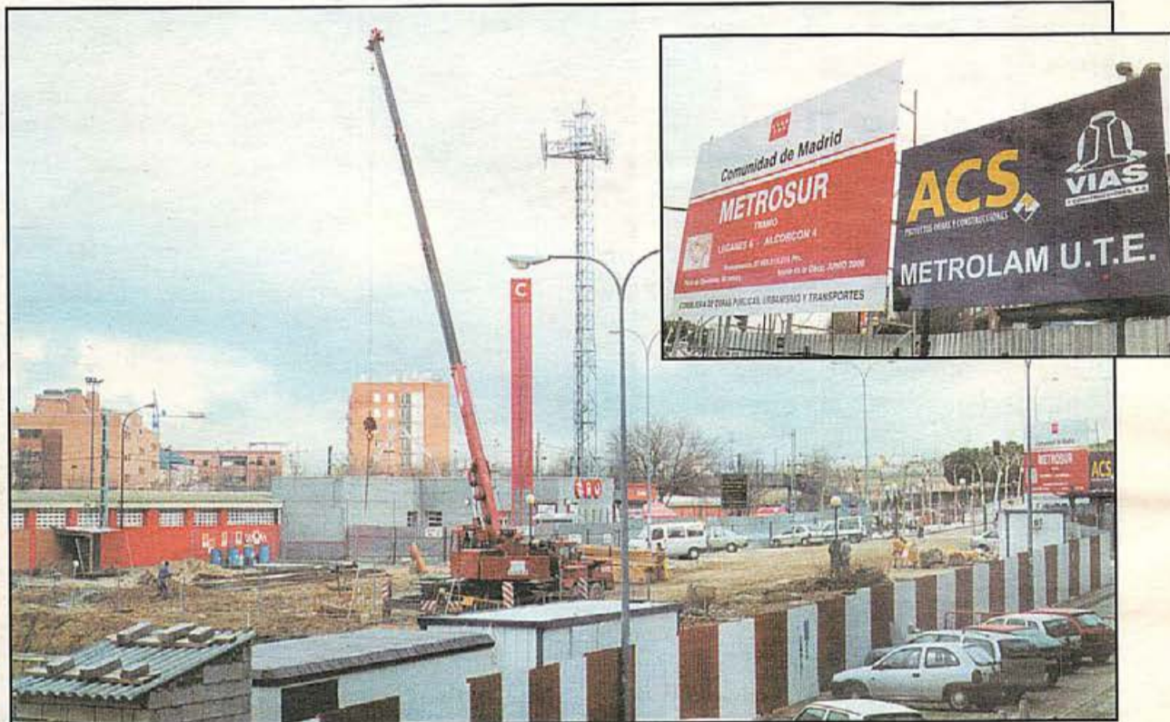
Vista parcial de las obras de Metrosur en la avenida de Móstoles
