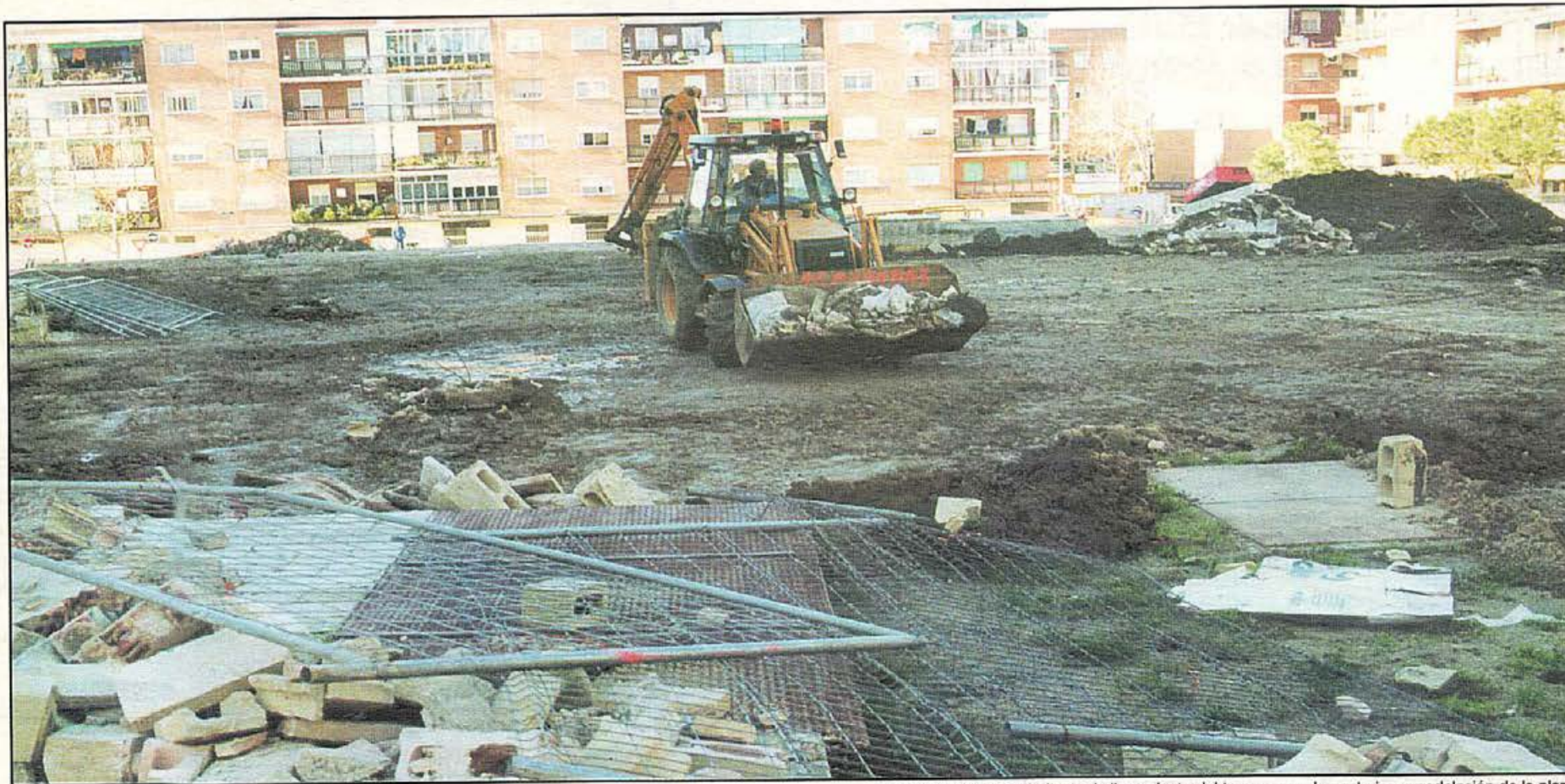
Una excavadora trabaja en el allanamiento del terreno para la posterior remodelación de la plaza
