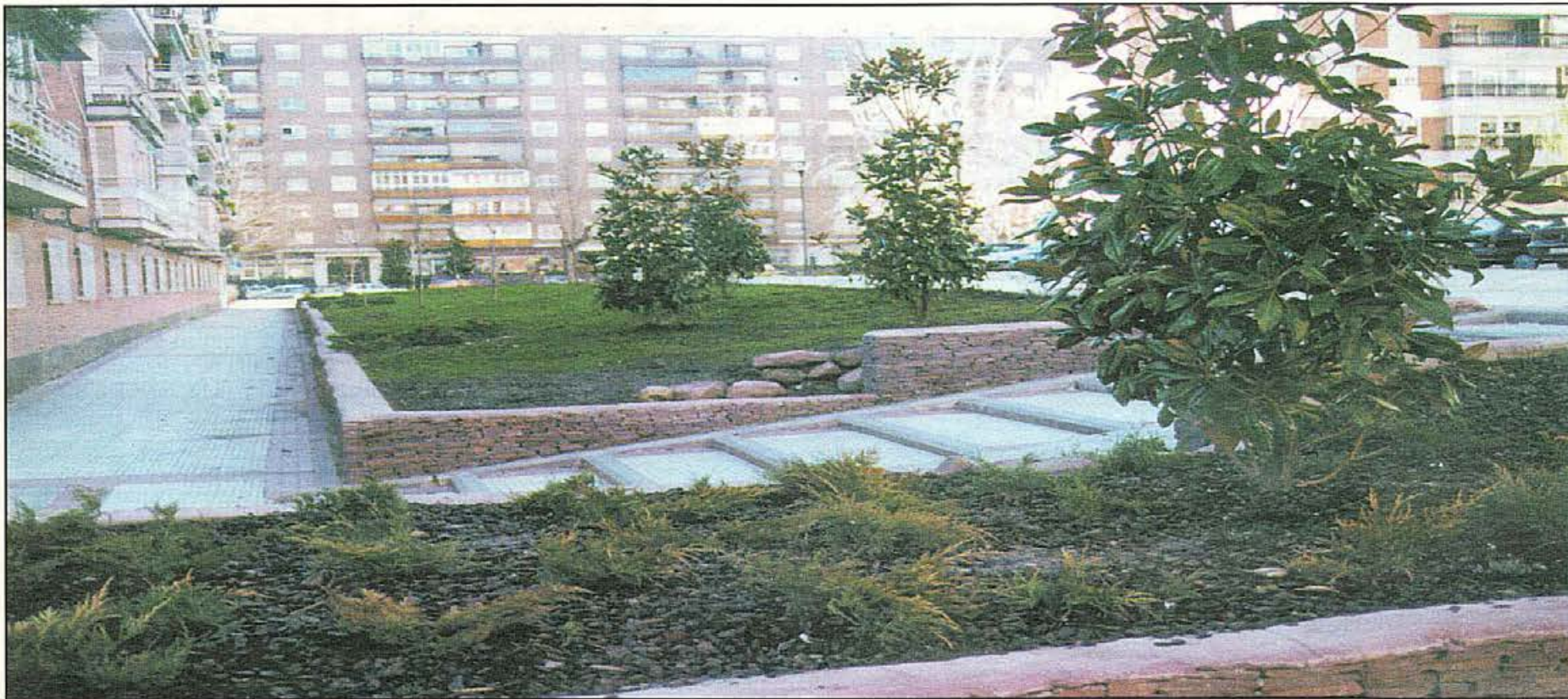
Vista panorámica de la calle Río Segre (posterior) que ha sido reordenada y ajardinada con diferentes especies
