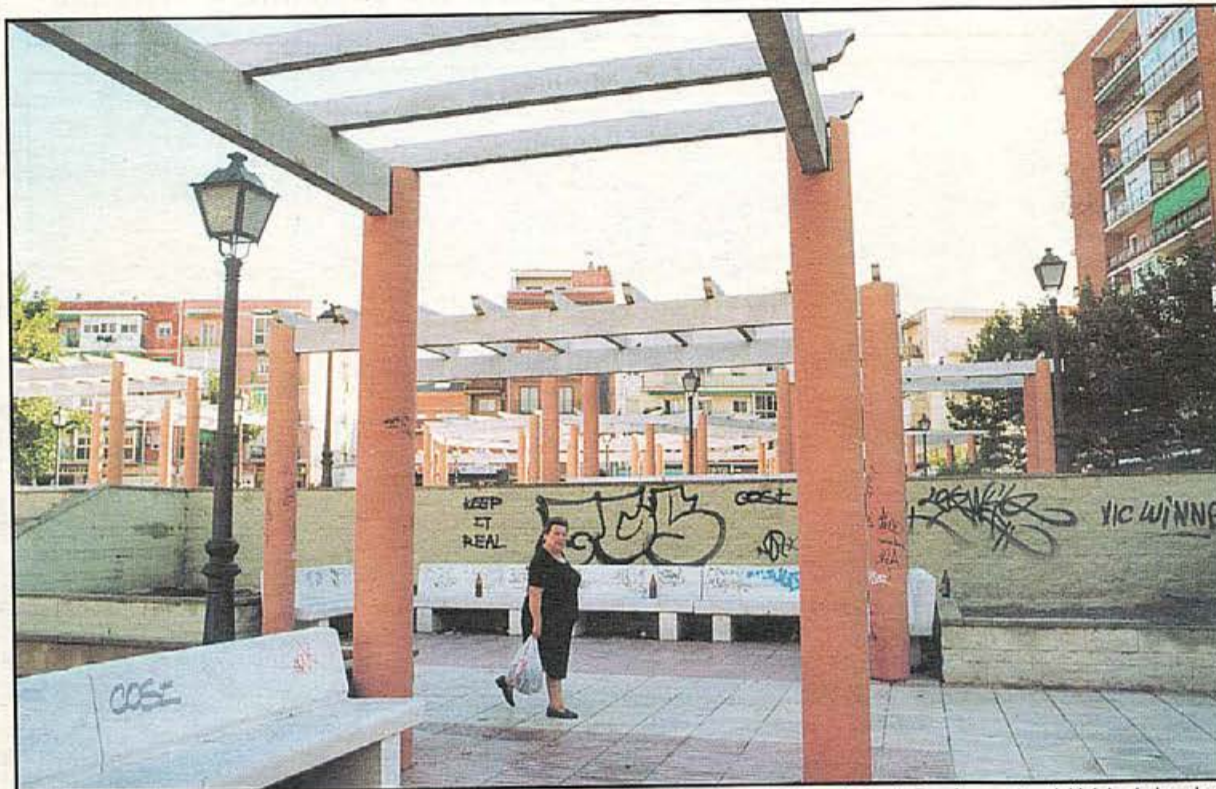
Imagen de la Plaza de Santo Domingo antes del inicio de las obras
