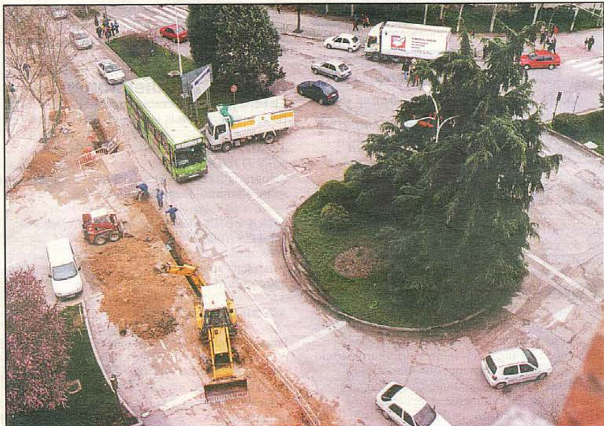
Vista aérea de las obras en la Avenida Alcalde José Aranda
