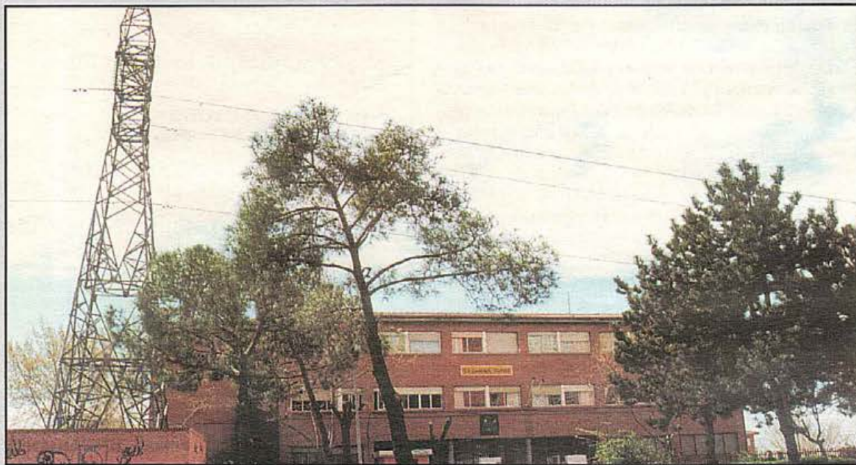
Vista de la línea que pasa sobre el Colegio Carmen Conde
