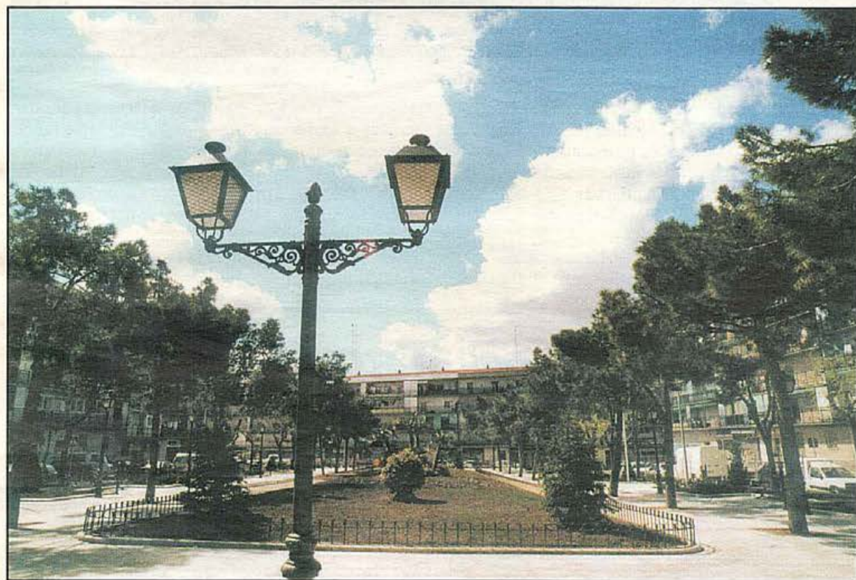
Vista panorámica del conjunto de la plaza tras la remodelación y adecuación del entorno
