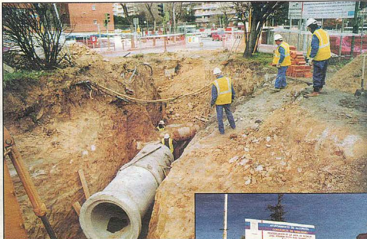
Obras del colector en la Avenida
