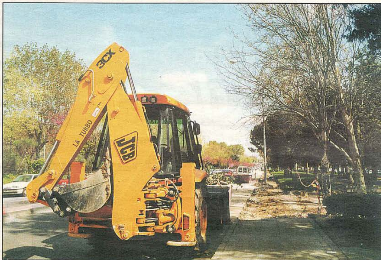
Máquinas que trabajan en la remodelación de la Avenida de Lisboa
