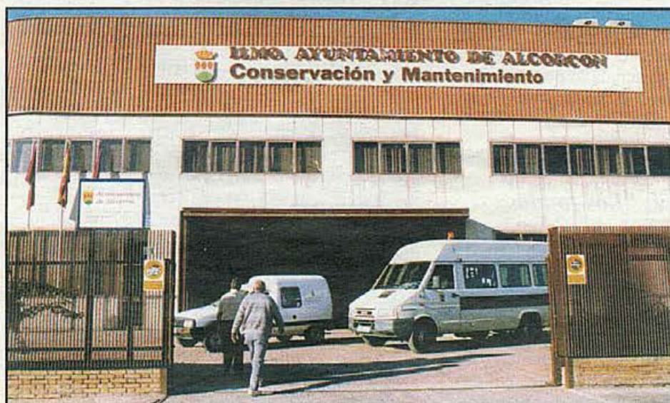
Entrada de las instalaciones de la Concejalía de Conservación y Mantenimiento de la ciudad
