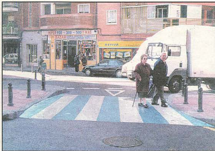
Uno de los pasos de peatones rebajados y pintados en calle La Huerta con calle San Pedro
