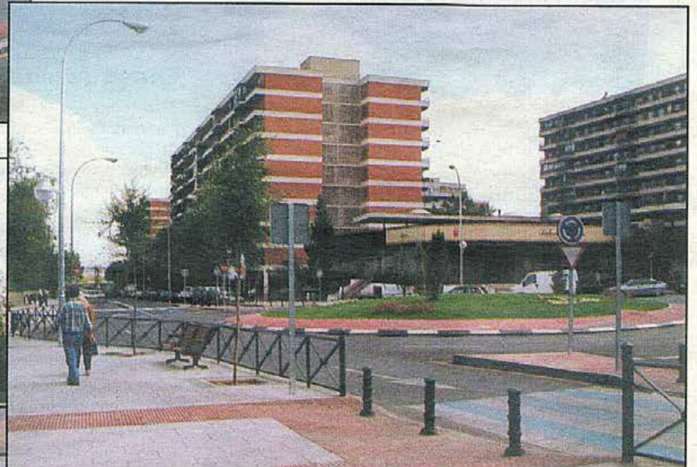
Glorieta en calle Polvoranca con calle Escolares
