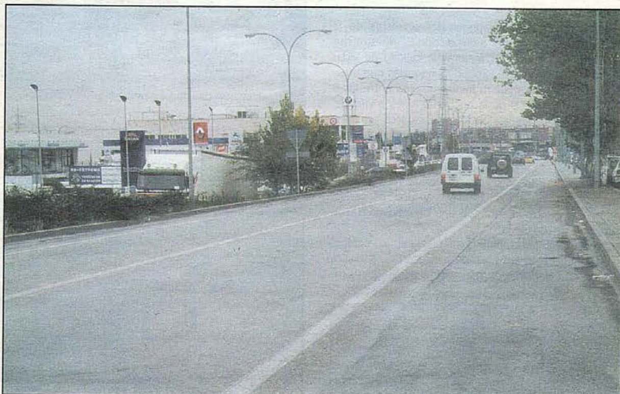
Vista actual de la M-501 o carretera de los pantanos en el término municipal de Alcorcón
