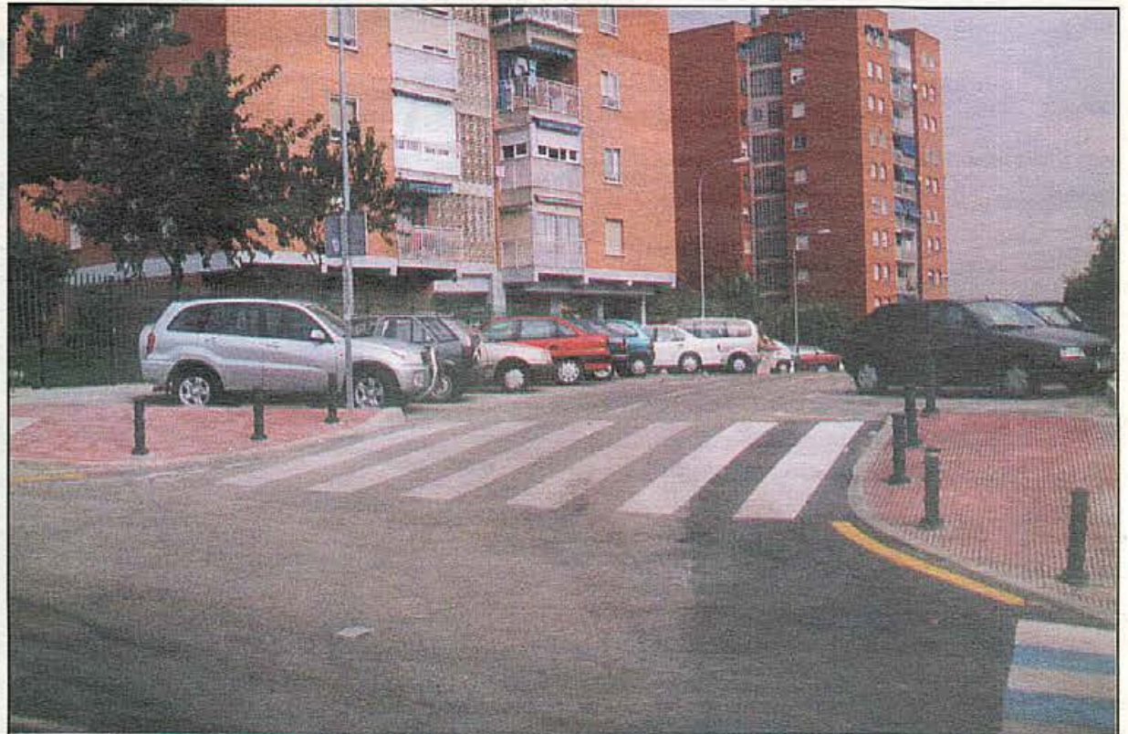
Rebaje de pasos de peatones y asfaltado, algunas de las actuaciones realizadas en Alcorcón II
