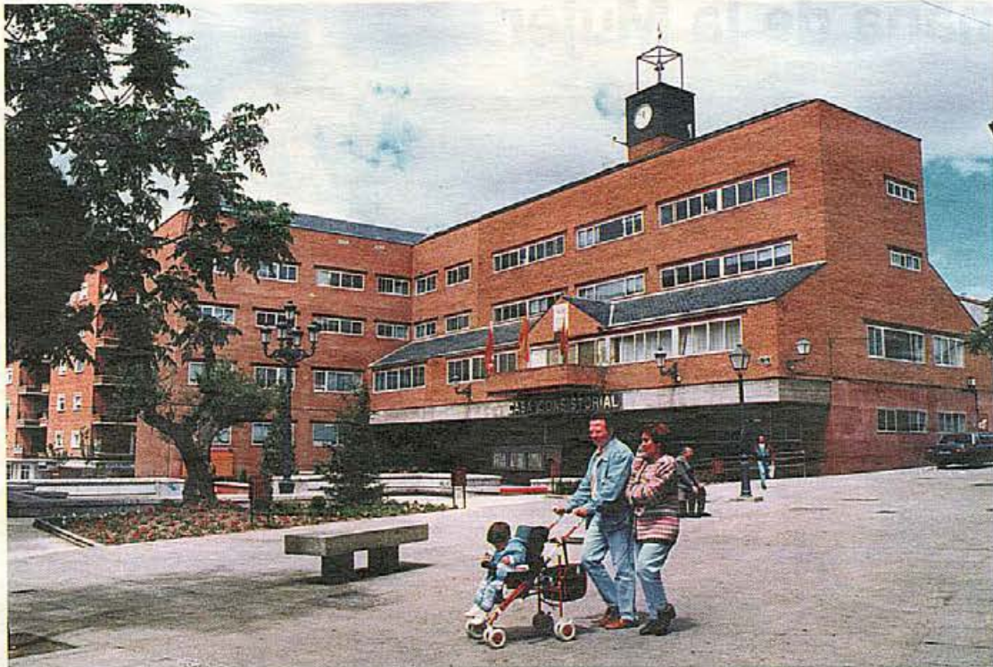
Junta de distrito nº 1, primera Planta del Ayuntamiento
