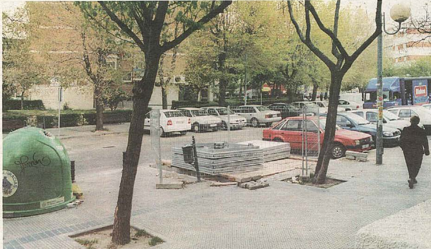
El nuevo sistema de recogida evitará la acumulación de residuos junto a los contenedores ya que estos estarán soterrados
