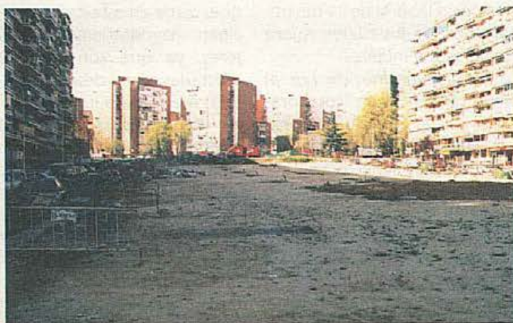
El aparcamiento tendrá un plazo de ejecución de trece meses
