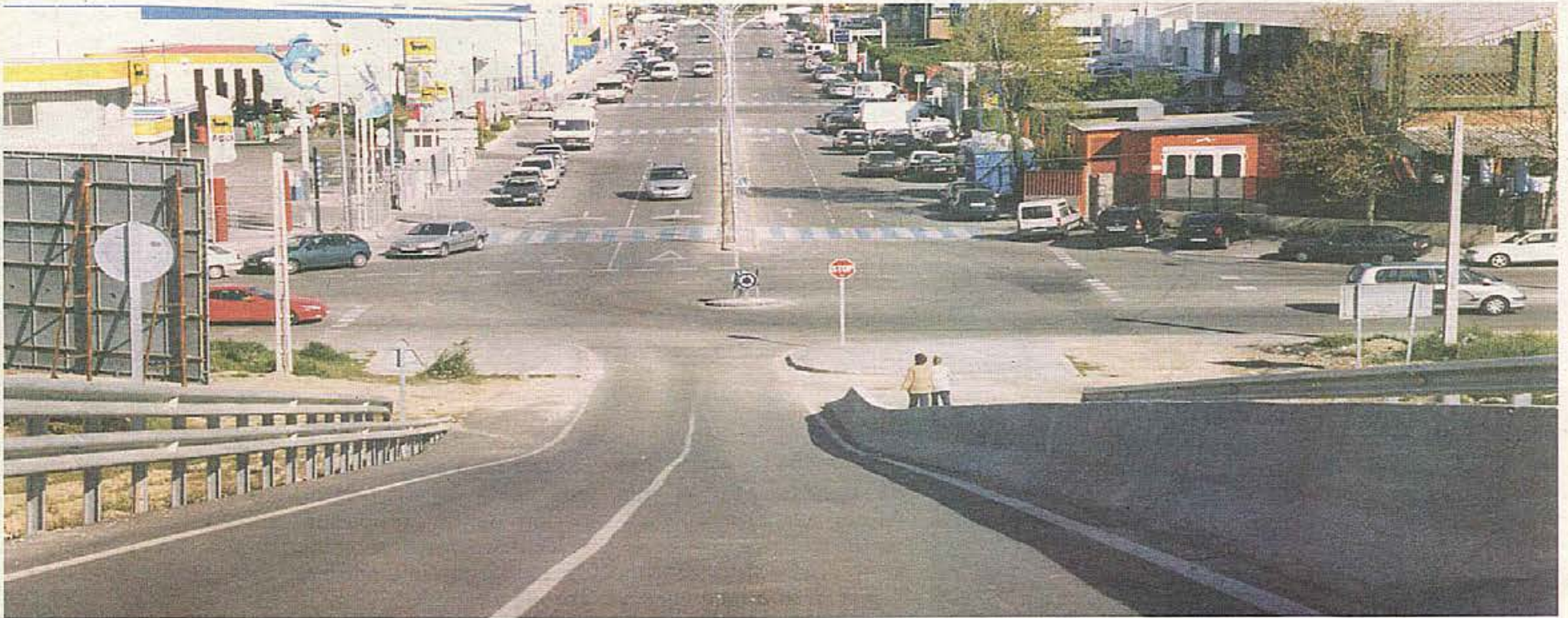
El paso sobre la Radial-5 ejecutado hace meses por el Ministerio de Fomento preocupa a los ciudadanos de Alcorcón
