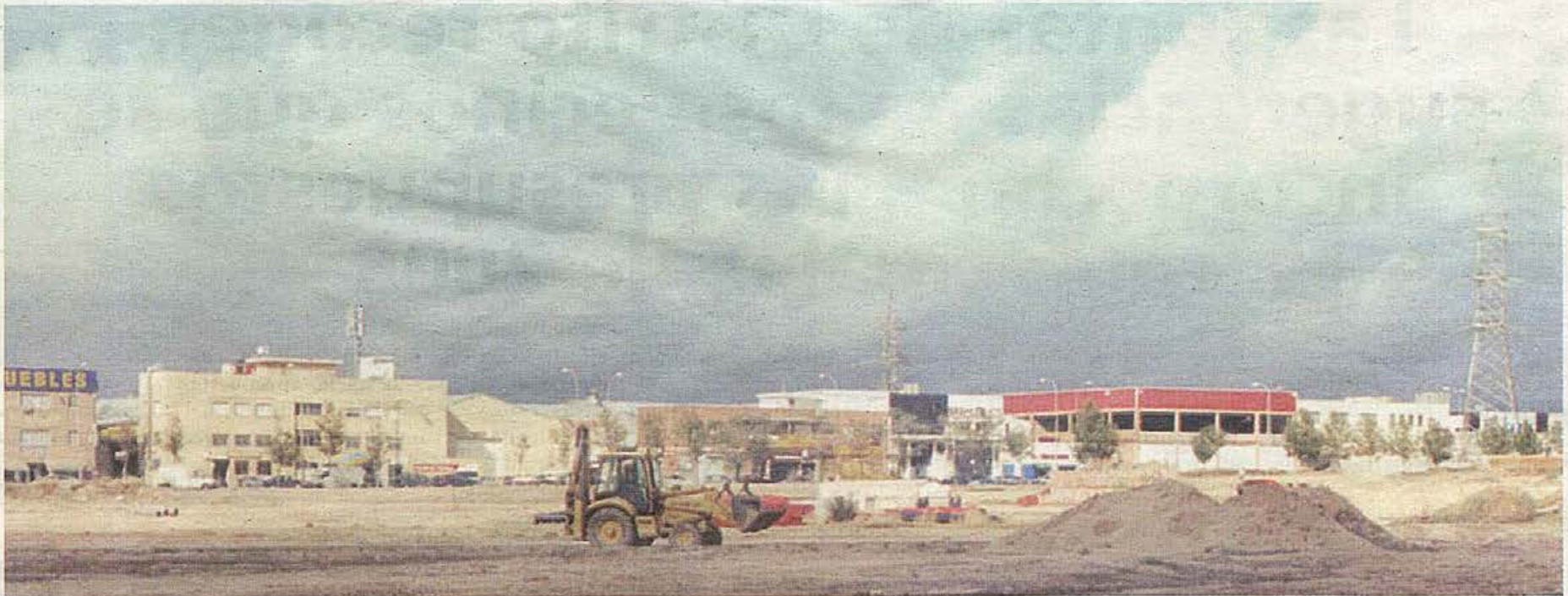
En la imagen las obras de urbanización del Polígono Industrial Ventorro del Cano
