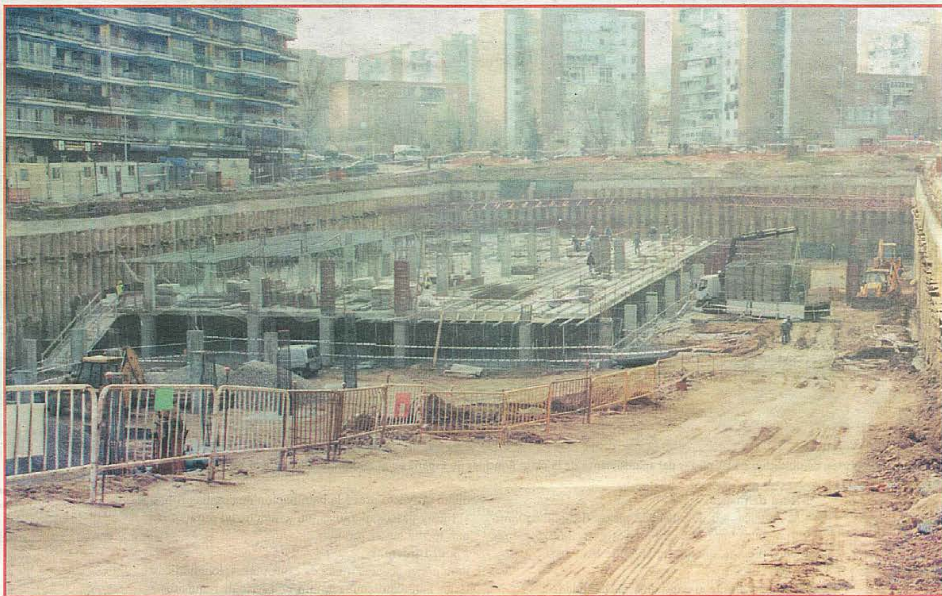
En la imagen, el estado de las obras del aparcamiento de la plaza Príncipes de España que comenzaron el pasado año.
