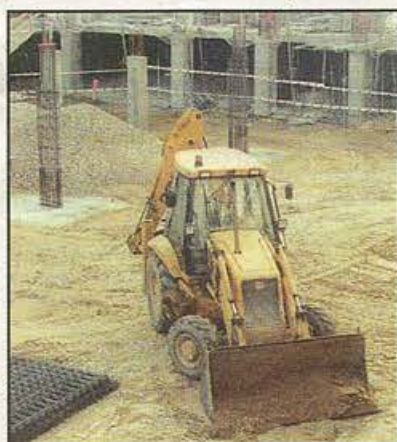
Obras en la Pza. Príncipes de España
