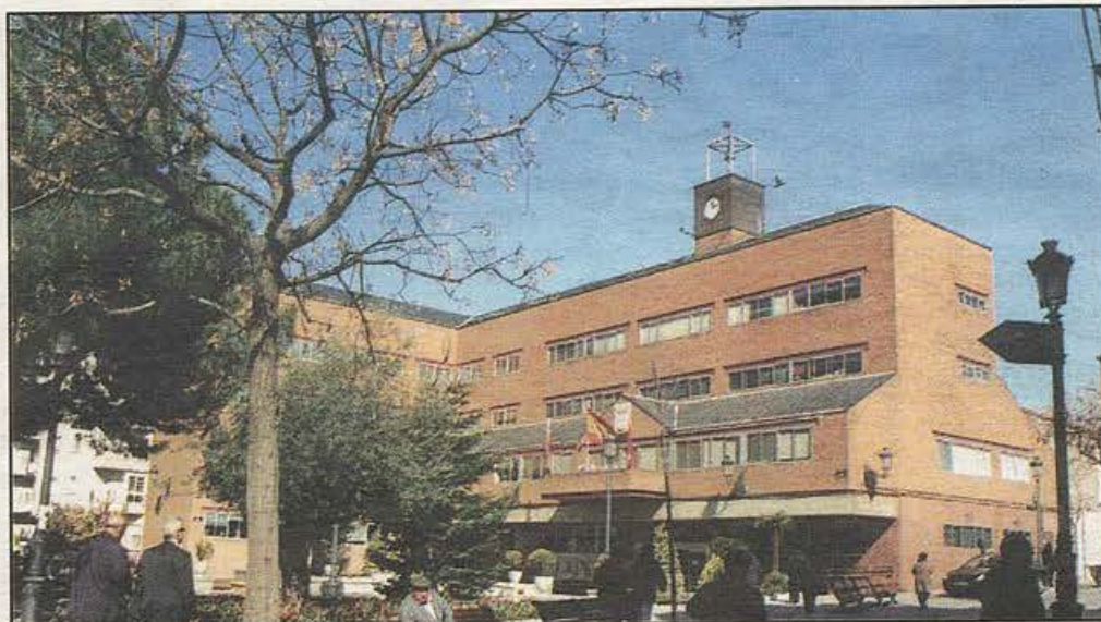
El nuevo edificio cambiará por completo la fisonomía del entorno del actual Ayuntamiento
