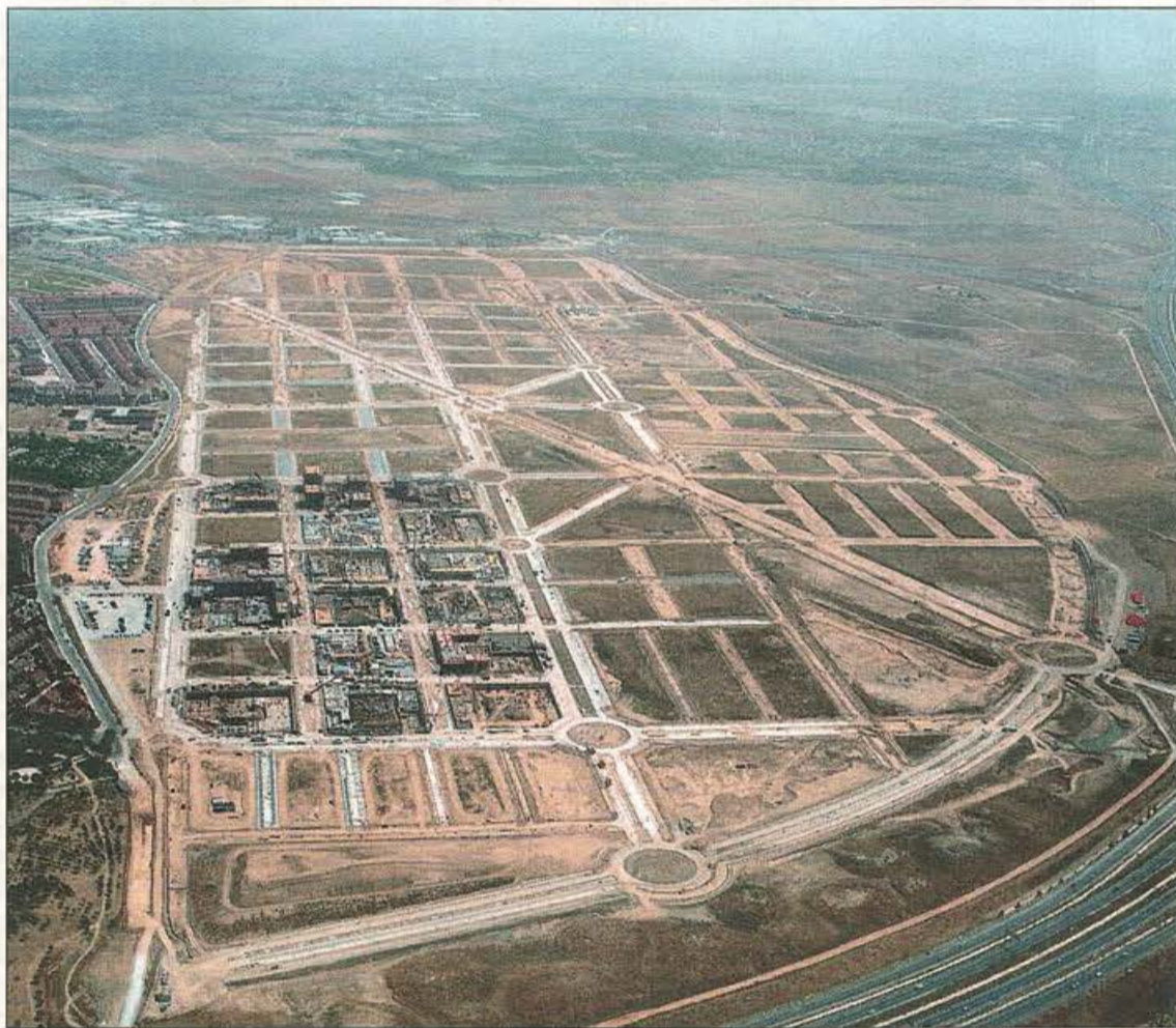
Vista aérea sobre el estado de las obras que actualmente se realizan en el Ensanche Sur
