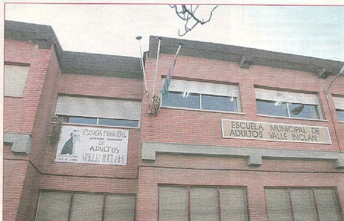
Esta escuela está ubicada en la Avenida Olímpico Francisco Fernández Ochoa
