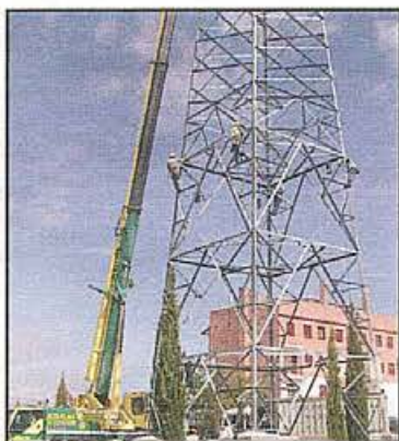
Se ha procedido al desmontaje de las torres
