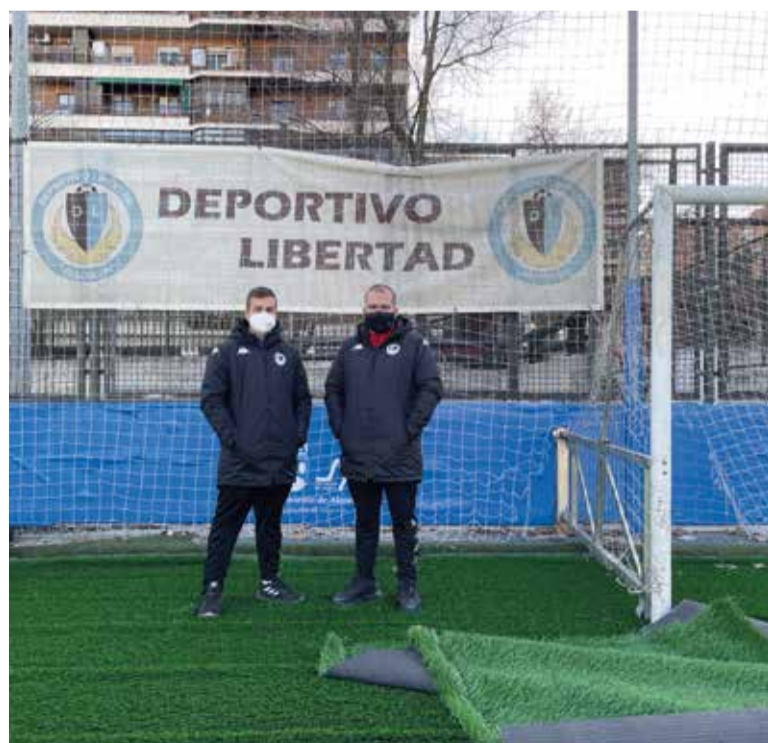
David Martín e Iván Sánchez muestran las obras del cambio de césped en las instalaciones 'Alfredo Cenarriaga'
